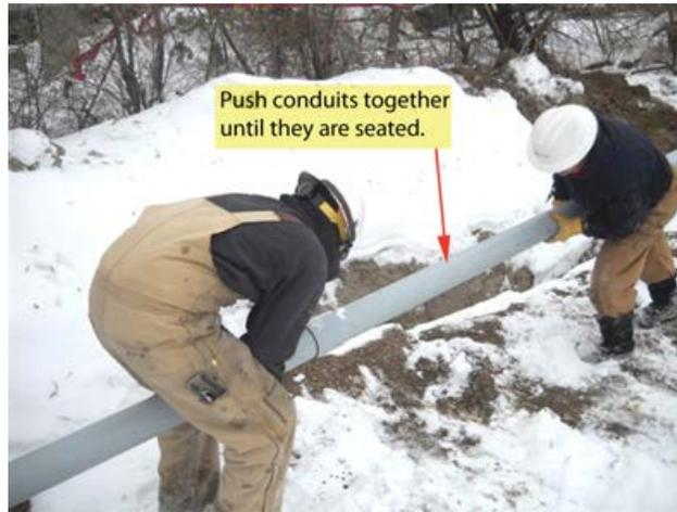
**Figure 26—Seating the Conduit**
