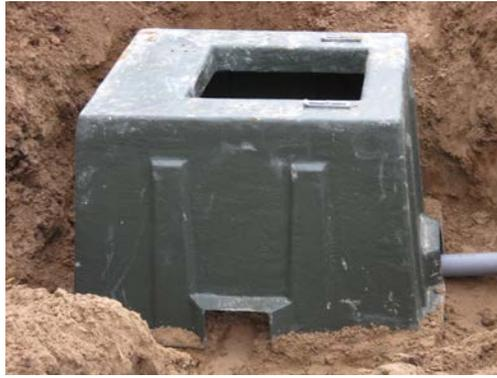
**Figure 42—24" Fiberglass Box Pad**
