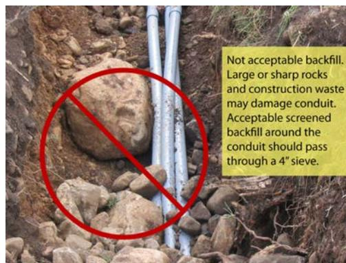
**Figure 16—Unacceptable Backfill**
