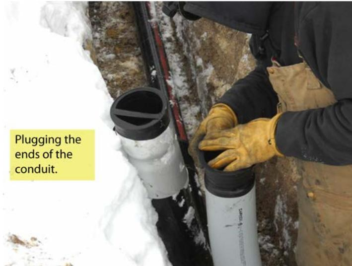
**Figure 29—Plugging the Conduit**
