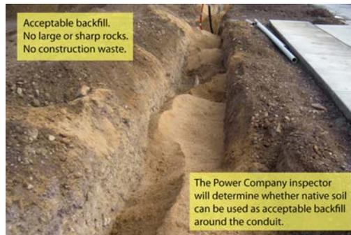
**Figure 15—Acceptable Backfill**
